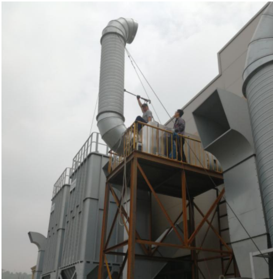
涂漆生产线废气活性炭吸附设施
